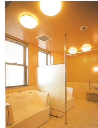
ユニット介護浴室
