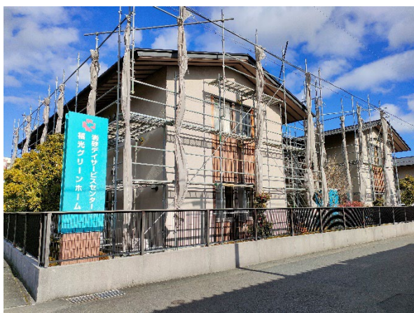
足場が組まれています。1階部分がひとい木です。
