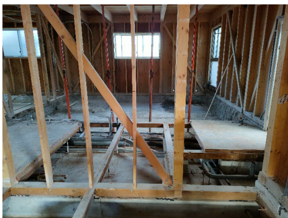
床を解体したところもあります。
